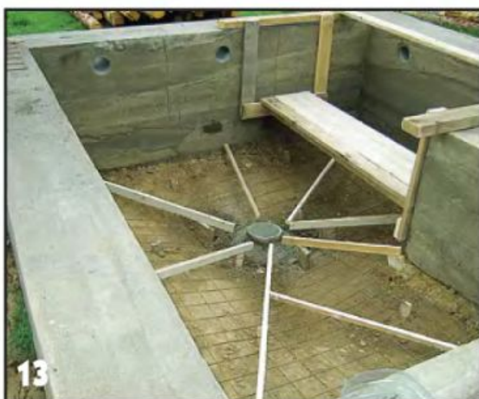
11 Примерно через неделю опалубку сняли и подправили цементным раствором небольшие дефекты фундамента. Щиты опалубки разобрали. Защищённые полиэтиленовой плёнкой доски и саморезы сохранились хорошо, поэтому они пригодятся для повторного использования.
