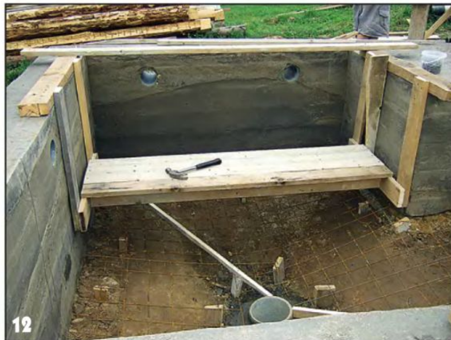
12 Ещё нужно было по нашему плану залить бетоном «корыто» под парной. Чтобы было удобнее работать, не ступая на грунт, собрали по месту переставные подмости.
