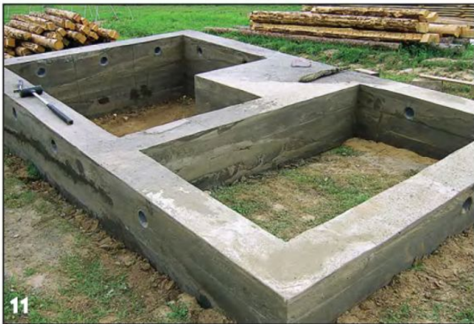
11 Примерно через неделю опалубку сняли и подправили цементным раствором небольшие дефекты фундамента. Щиты опалубки разобрали. Защищённые полиэтиленовой плёнкой доски и саморезы сохранились хорошо, поэтому они пригодятся для повторного использования.
