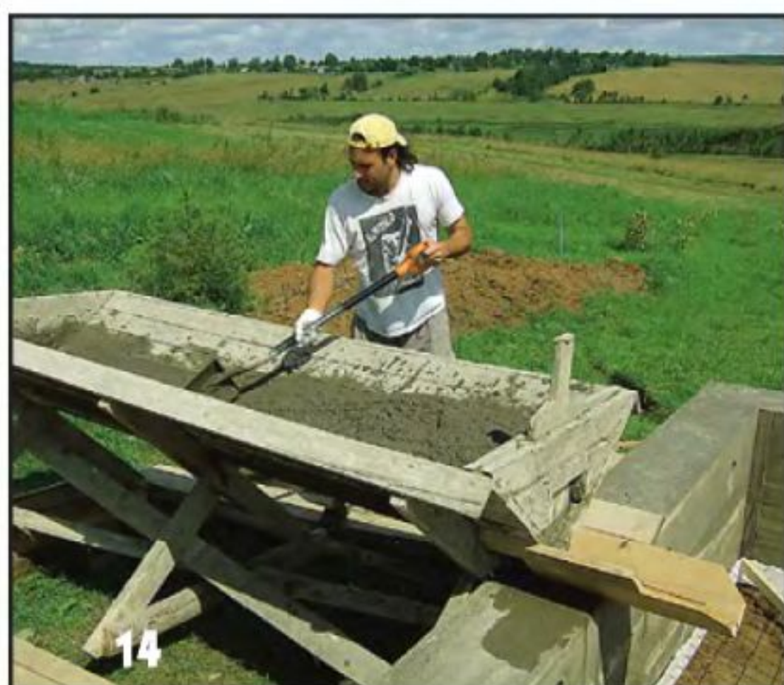
14 Для заливки бетоном «корыта» пришлось приподнять «бетономешалку» над фундаментом и приладить к ней лоток.
