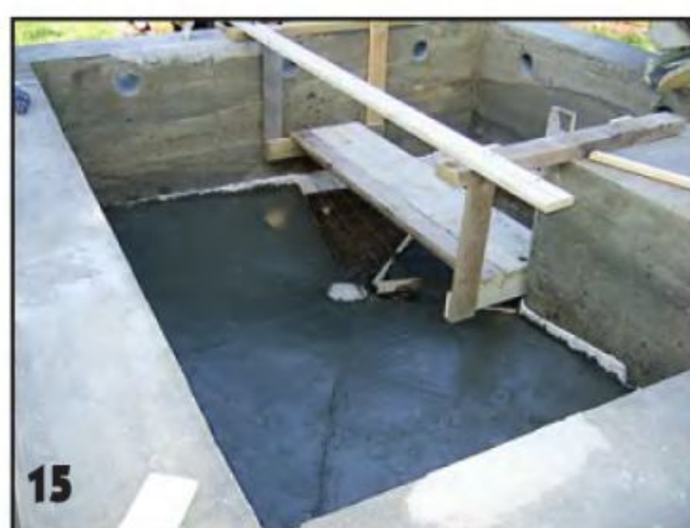
15 На всякий случай решили развязать бетонное «корыто» и фундамент. Для этого вдоль внутренних стенок фундамента перед заливкой «корыта» проложили ленты из пенополиэтилена толщиной 10 мм. Входное отверстие сливной трубы плотно заби́ли скомканной полиэтиленовой плёнкой, чтобы случайно не забетонировать и трубу.
