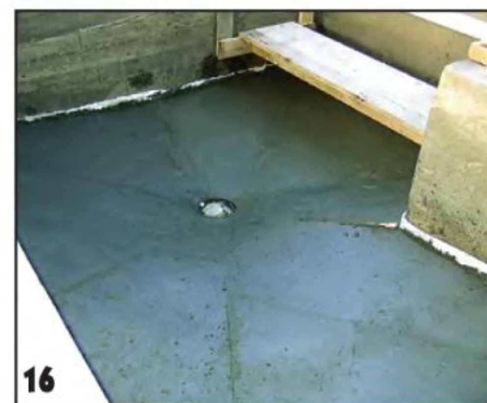
16 Деревянные маяки и пенополиэтиленовые прокладки извлекать из бетона не стали — они будут как-то компенсировать деформационные нагрузки.
