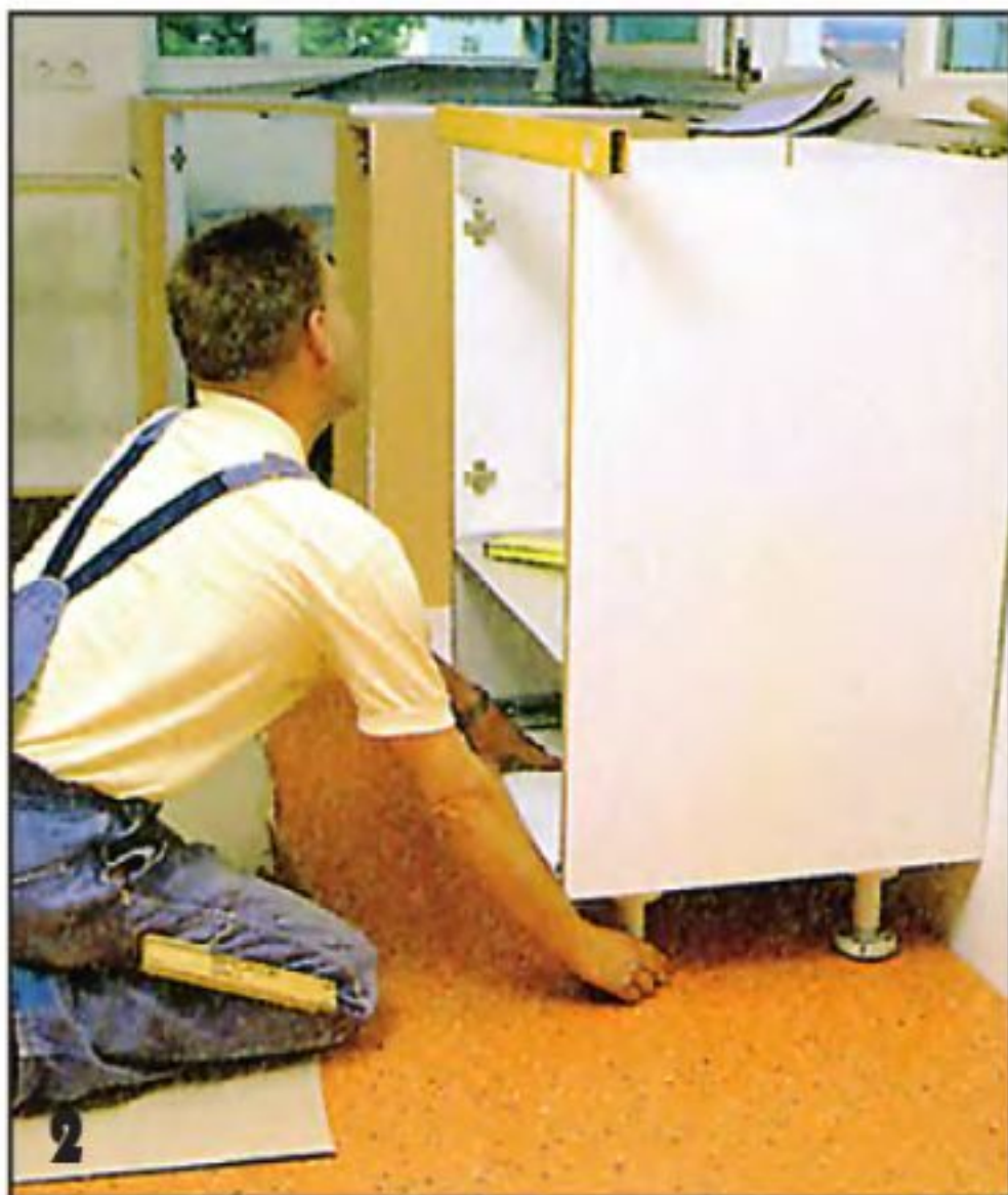
2 Установленные вдоль окна тумбы, регулируя винтовые ножки, поднимают до уровня верхней кромки подоконной стенки.
